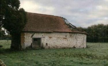
Façade maçonnée en brique et silex enduit.<br>Couverture en tuile. |
