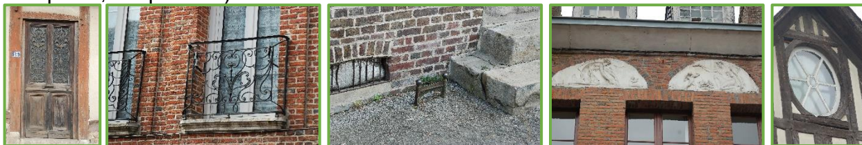
Exemples de détails architecturaux à conserver
